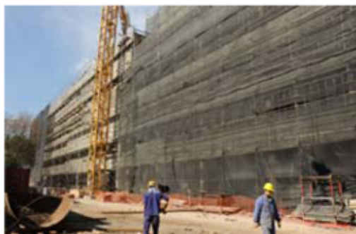
Fachada ventilada en el lateral sobre Juan B. Justo.
