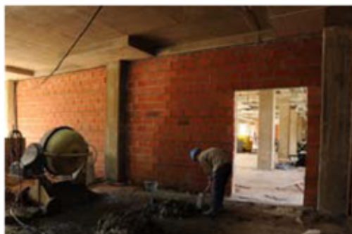
Muro de ladrillos emplazado en el edificio Blanco - Agencia.
