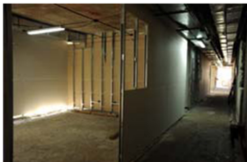
Vista interior del edificio Nuevo - Institutos.
