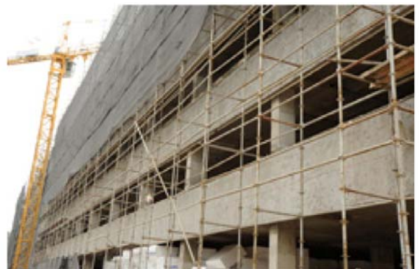
Fachada ventilada del edificio Nuevo – Institutos.
