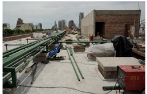
Vista de las azoteas.
