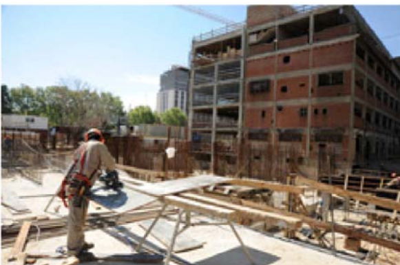
Trabajos de carpintería sobre el sector de la futura torre del CONICET. Al fondo, el Edificio Rojo – Ministerio.
