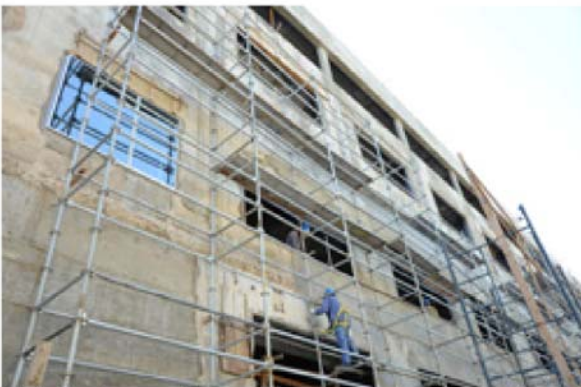
Personal de la obra realiza terminaciones de ajuste sobre el lateral del Edificio Blanco – Agencia
