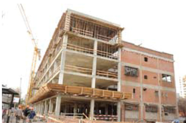
Losas sobre 3º y 4º piso del Edificio Nuevo - Ministerio
