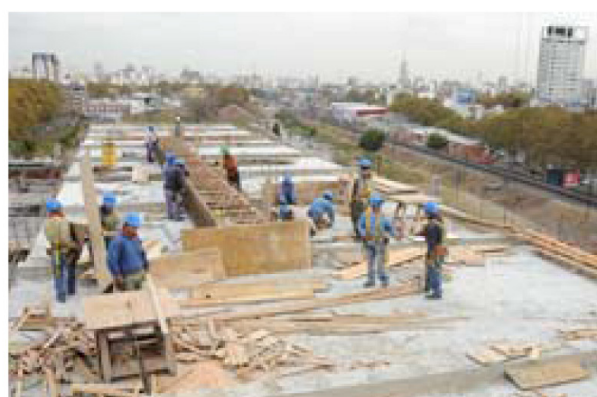
Vista superior del Edificio Nuevo – Ministerio, durante la construcción de la lucarna.
