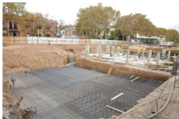
Armaduras de la platea del edificio del CONICET.
