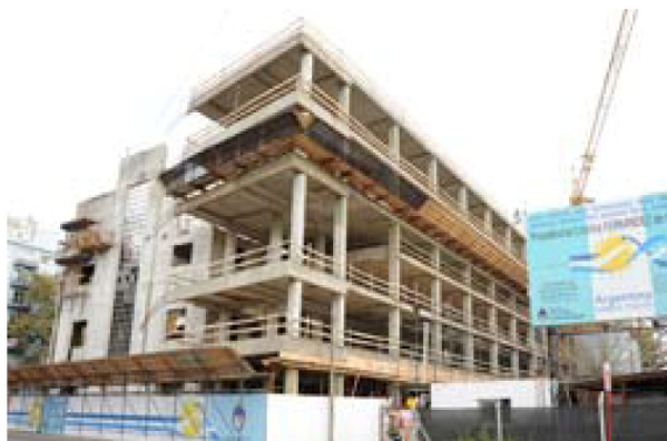
Vista lateral de los edificios Blanco y Nuevo – Institutos, desde la calle Paraguay.
