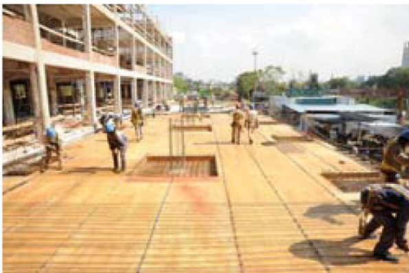
Losa del primer piso del Edificio Nuevo - Ministerio.
