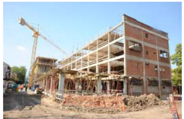
Vista lateral del Edificio Rojo existente y parte del Edificio Nuevo.
