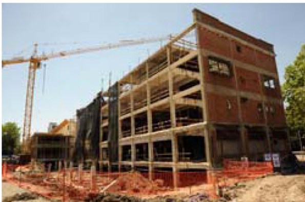
Contrafrente del Edificio Rojo demolido
