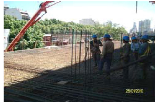
Hierro de las estructuras de la losa.
