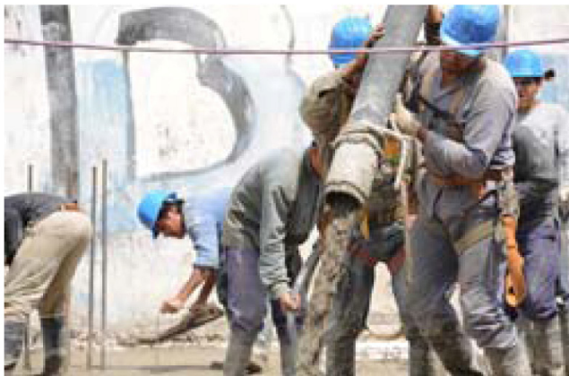
Llenado de losas con hormigón.
