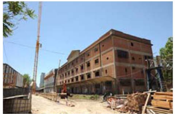
Vista lateral del Edificio Rojo, previo al inicio de las demoliciones.
