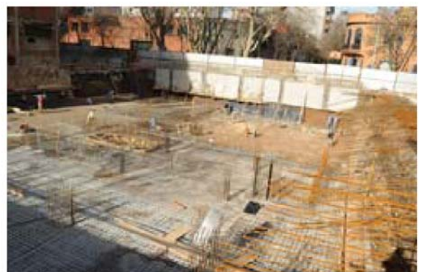
Platea del edificio del Conicet, durante las tareas de armado y hormigonado.
