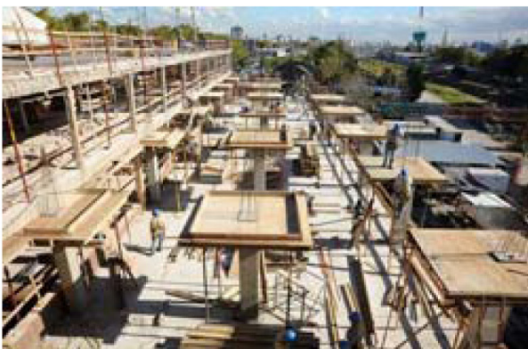
Encofrados del Edificio Nuevo – Institutos.
