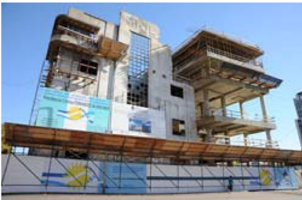
Vista de los edificios Blanco y Nuevo – Institutos, desde la calle Paraguay.
