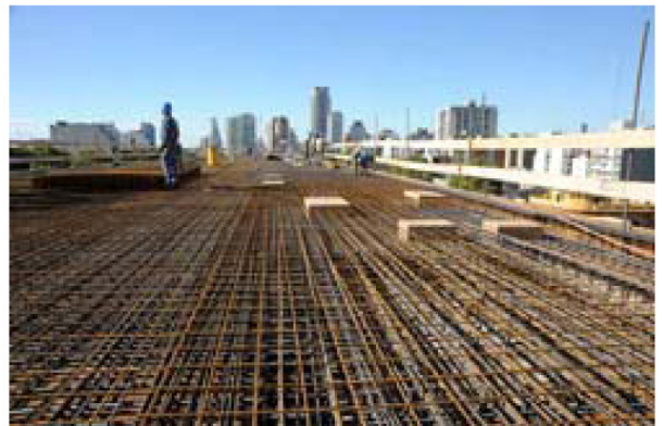
Hierros de la estructura del Edificio Blanco.
