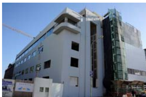
Vista actual del Polo Científico Tecnológico. Las estructuras se mantuvieron y fueron revalorizadas.
