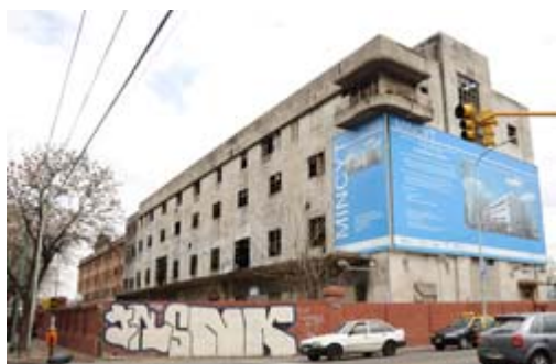
Así se encontraban las estructuras de las ex bodegas Giol al iniciarse la obra.
