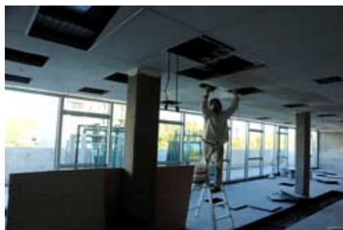
Un obrero trabaja en el cielorraso del Edificio Rojo – Ministerio.
