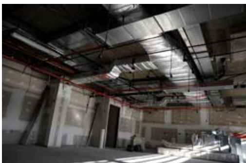
Vista interna del cuarto piso del Edificio Blanco.
