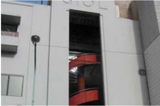
Vista de la escalera helicoidal del edificio Blanco – Agencia.
