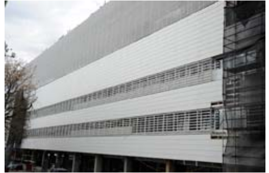
Vista de la fachada ventilada.
