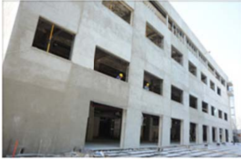
Vista lateral de la antigua fachada restaurada, perteneciente al Edificio Blanco – Agencia.
