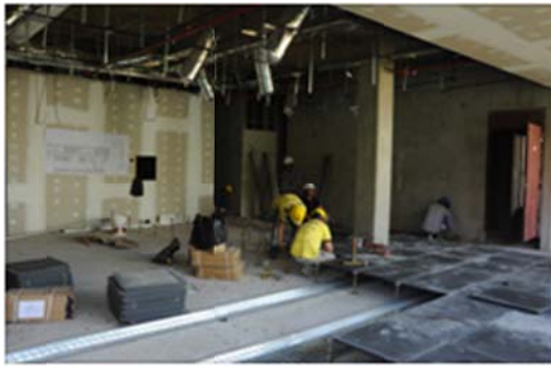
Armado del piso técnico en el Edificio Blanco - Agencia.
