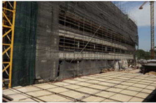
Placas listas para colocarse sobre la fachada ventilada.
