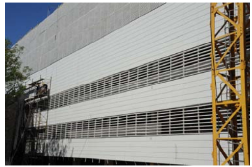
Fachada ventilada, Edificio Nuevo – Institutos.
