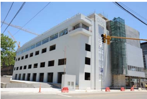
Vista desde la calle Paraguay de la fachada restaurada del Edificio Blanco – Agencia.
