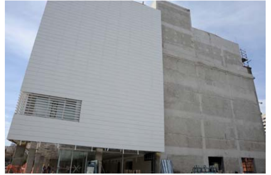
Fachada hacia la calle Soler del Edificio Nuevo – Ministerio.
